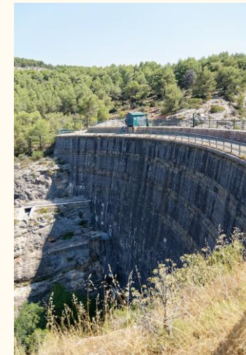
« Zola » dam (France)
