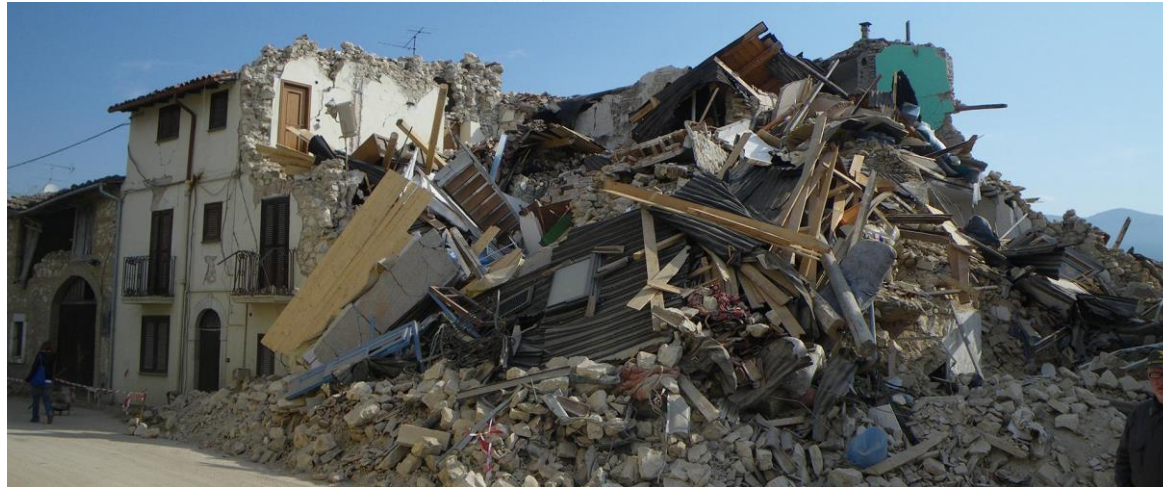
Séisme du Teil - 11 novembre 2019
